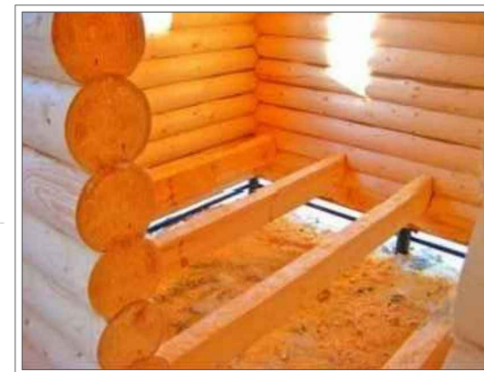
Примерный вид врезанных лаг пола между нижними венца бревенчатого сруба.
