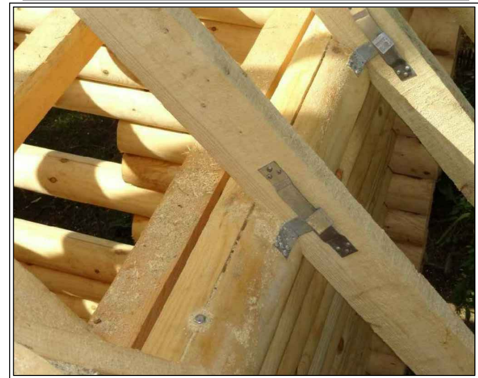
Примерный вид установки консольной подкровельной балки на колонну с компенсатором.
