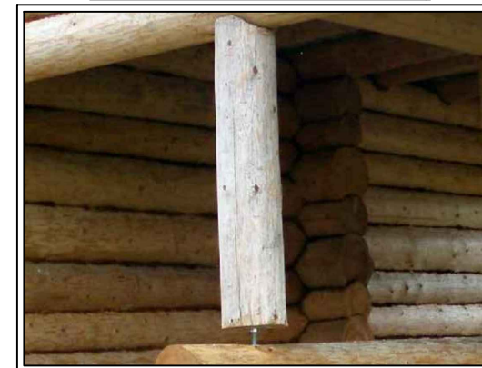
Примерный вид установки консольной подкровельной балки на колонну с компенсатором.
