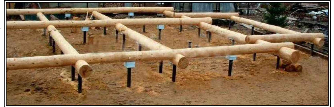
Примерный вид врезанных лаг пола между нижними венца бревенчатого сруба.
